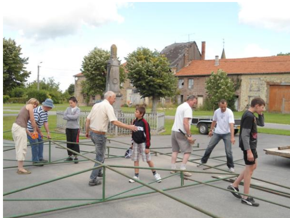
Mise en place des chapiteaux sur la place
