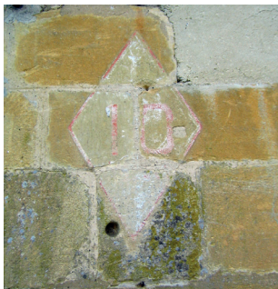
Ce losange est encore visible au 4 rue d'Orthez...
